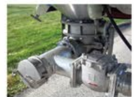
Tapa de inspección delantera de las tuberías
